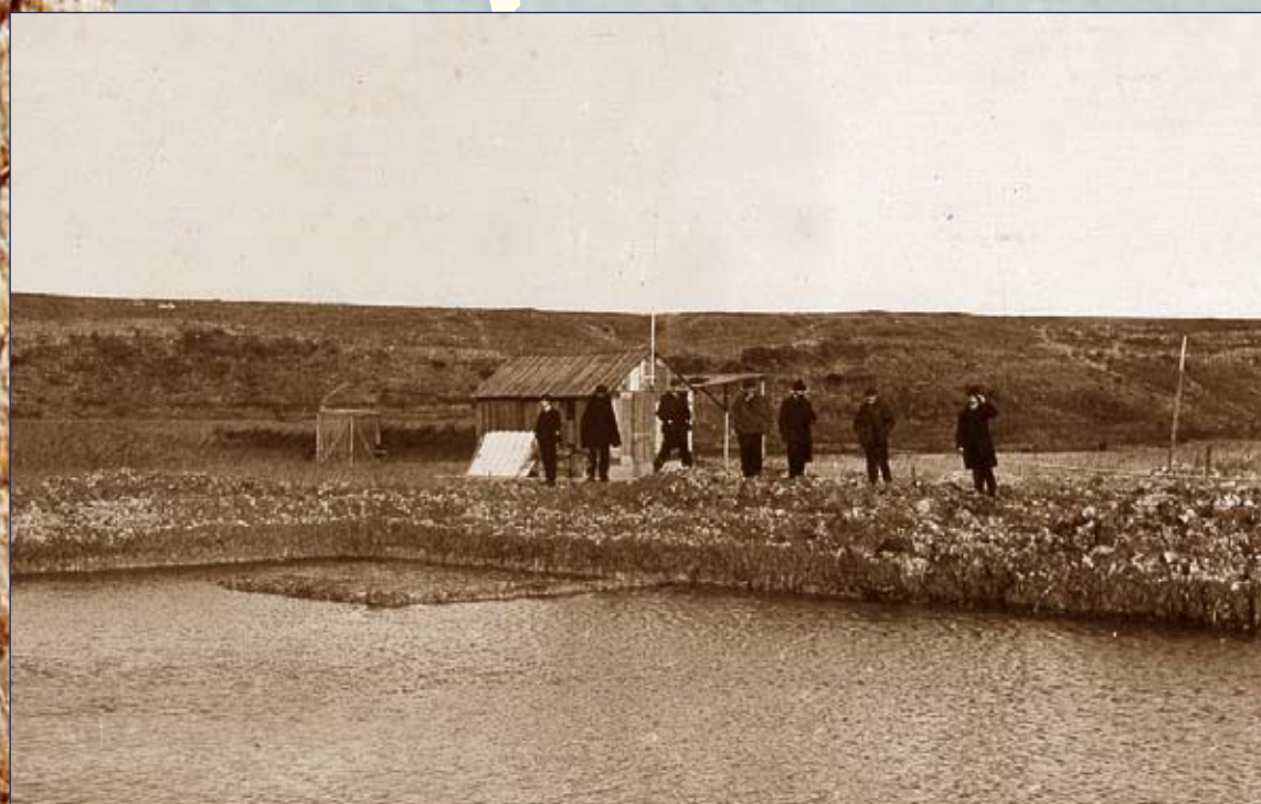
Début des travaux du port (1907) [AD Aude, 38 Dv 1/128]
