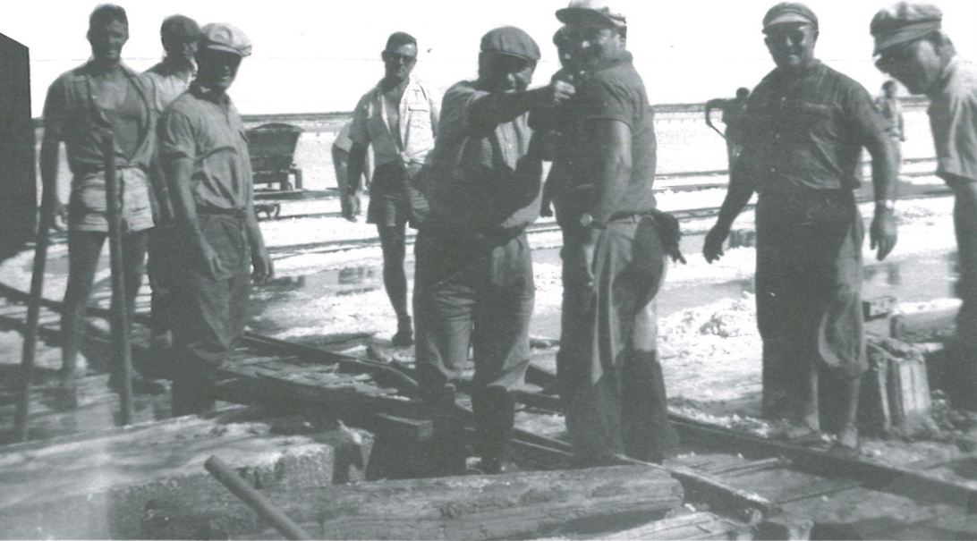
installation des voies des tracteurs crochas
