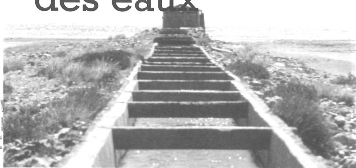
une station de pompage sur le salin de Gruissan
