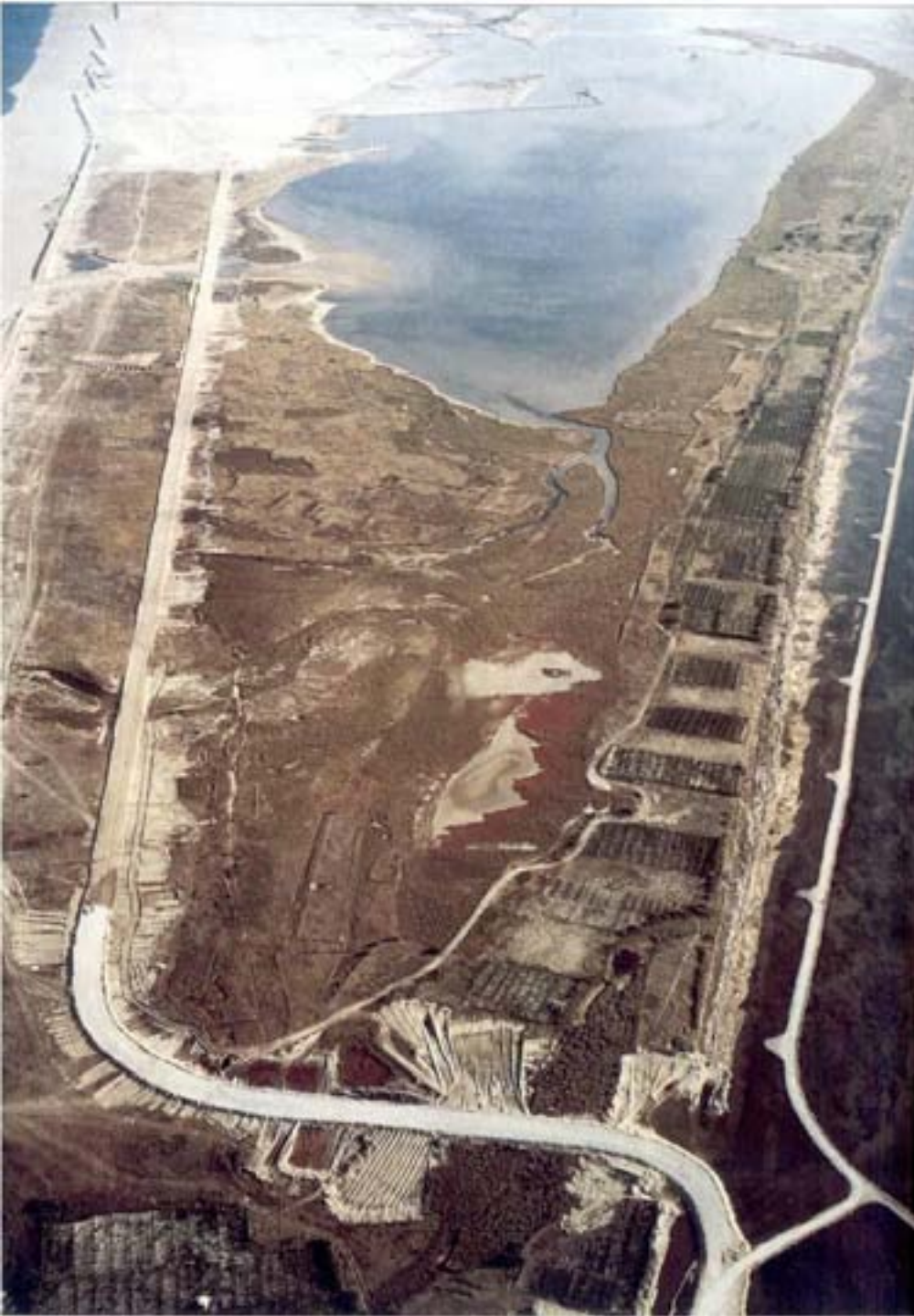
Chantier, vers 1965 – Col J. Hiron
